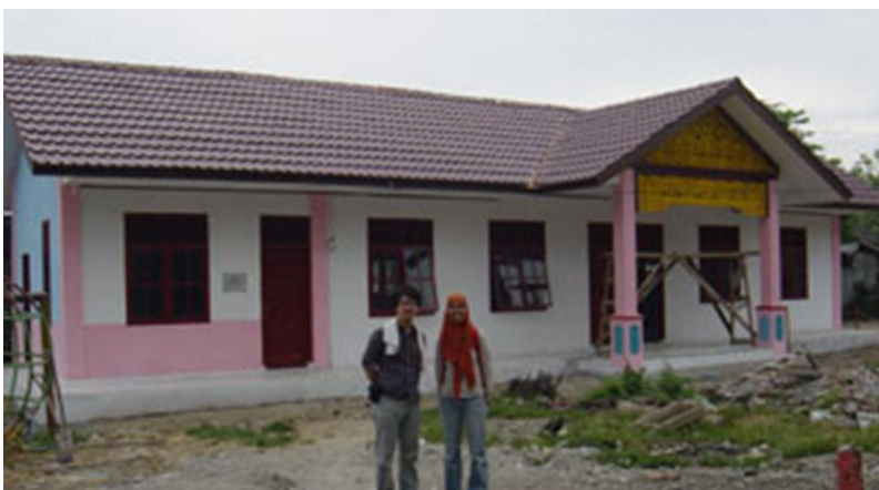
2006年1月撮影（建設中の幼稚園）
